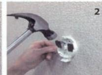
2. 固定金具をハンマーで打ち込みます。金具の打ち込み角度にご注意ください。
